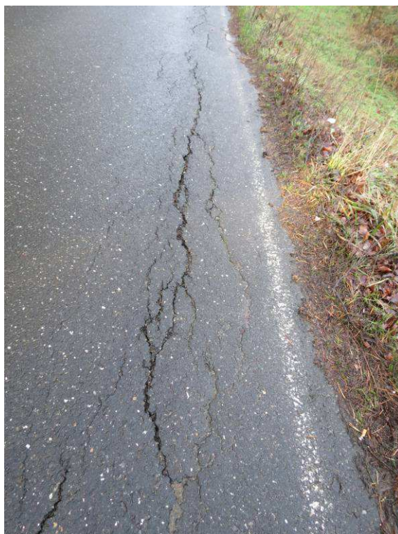
Obr.3.C Poruchy povrchu vozovky
