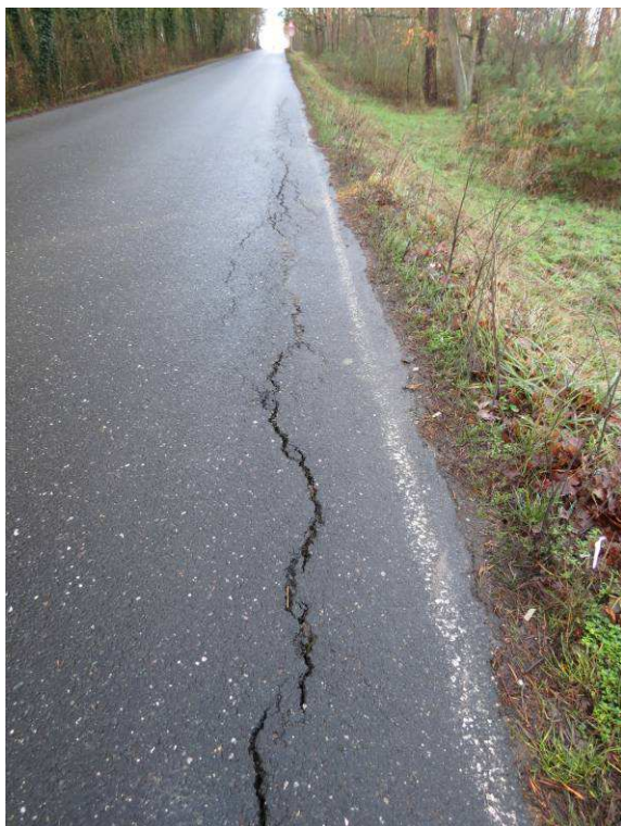
Obr.1.C Poruchy povrchu vozovky v místě sondy č.1
