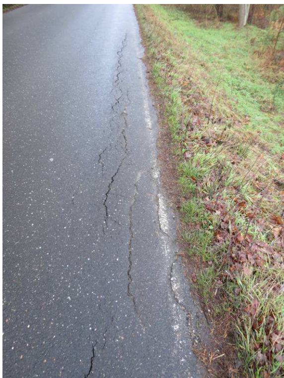
Obr.2.C Poruchy povrchu vozovky
